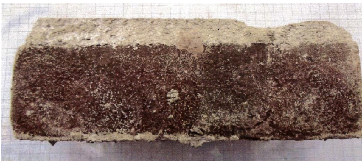
Obr.2 – Ošetrená tehla injektážnou hmotou
